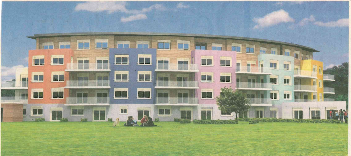
Der erste Spatenstich ist gesetzt: In zwei Jahren soll die Vaubanaise zeigen, wie Pflegebedürftige wirklich integriert werden können. FOTO: ZVG
